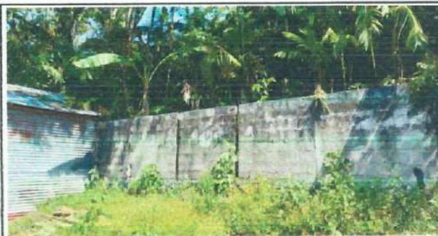
Foto 10: Lado Noroeste faltan 3 filas de block, solera y fundición de columnas.
