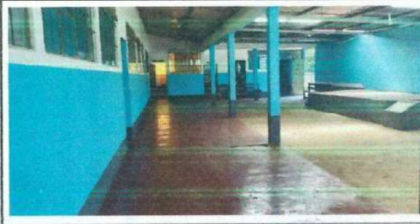
Foto 6: Sustitución de torta de concreto dañada por piso cerámico en el corredor de los módulos de Cuarto, Quinto y Sexto Primaria.
