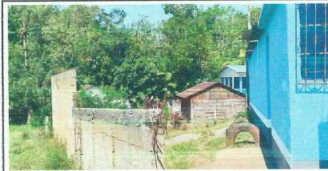
Foto 12: Lado Sur entrada principal al establecimiento, faltan 5 filas de Block, solera y fundición de columnas.
