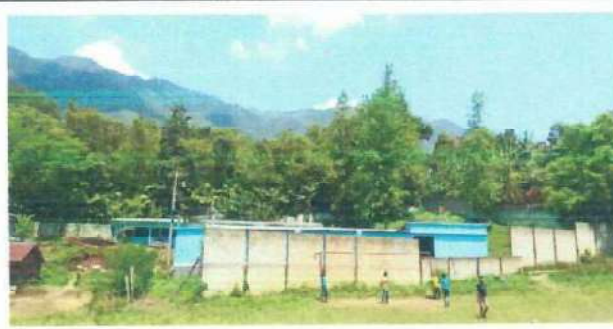
Foto 8: MURO PERIMETRAL: Se mejorará el 30 % del muro perimetral para el resguardo tanto de los niños en horario de clases así como de las instalaciones de la escuela fuera del horario laboral.
